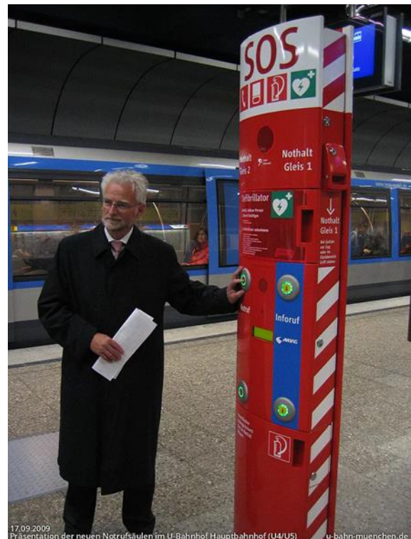
Abbildung 17: Kombinierte Info- und Notrufsäule in der Münchner U-Bahn
